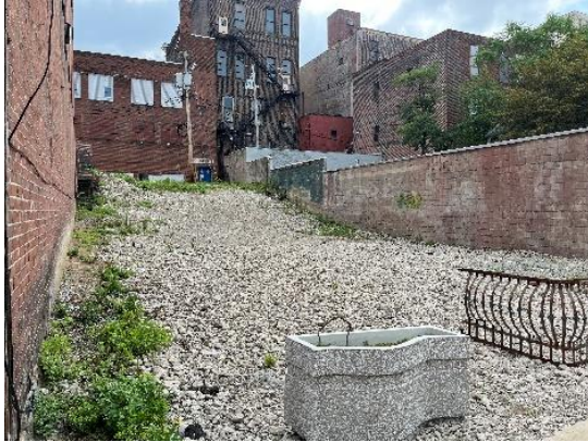
Site: 127 S. Pennsylvania Ave.
